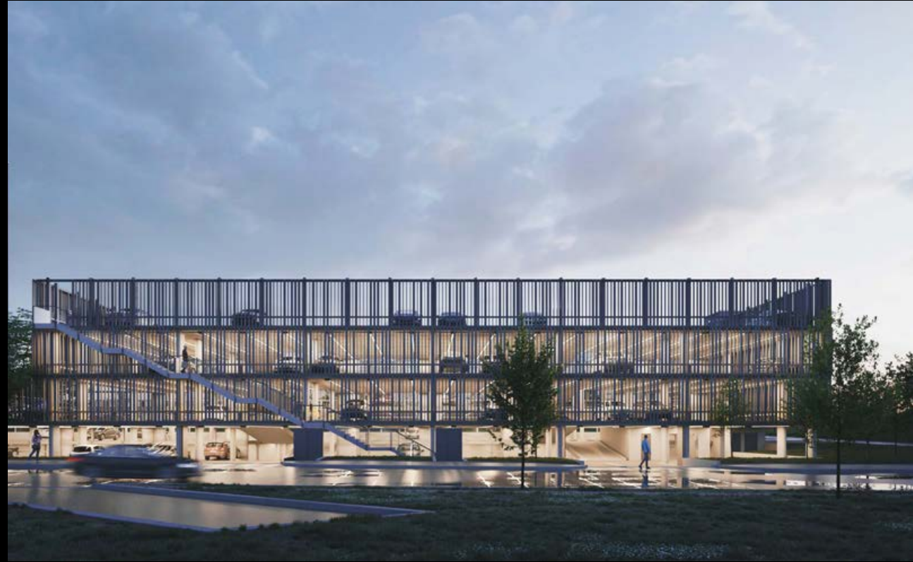
Parkovací dům Nové Butovice, Praha 13, Prague 13
