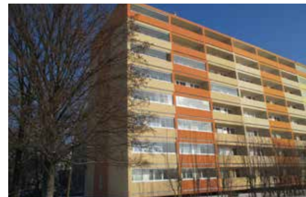
REVITALIZACE BYTOVÉHO DOMU BŘEZINOVA, KOLÍN / REVITALIZATION OF THE BŘEZINOVA APARTMENT HOUSE, KOLÍN
