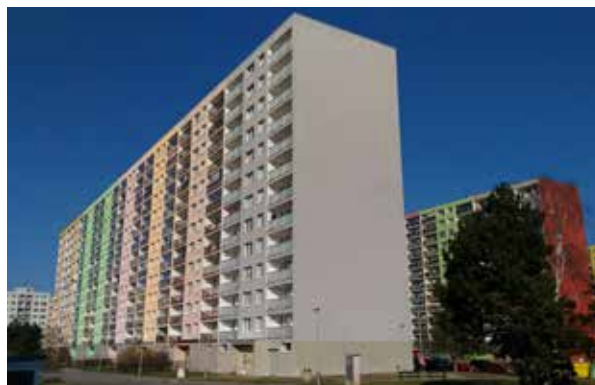
ZATEPLENÍ OBVODOVÉHO PLÁŠTĚ A OPRAVA LODŽIÍ BYTOVÉHO DOMU PAVLÍKOVA, PRAHA 4 / INSULATION OF THE SHELL AND REPAIR OF THE LOGGIA OF PAVLÍKOVA APARTMENT HOUSE, PRAGUE 4
