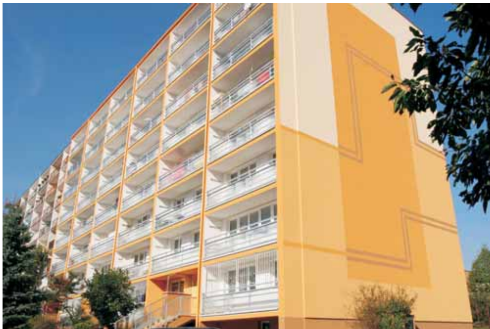
Zateplení bytového domu Nevanova, Praha 6, 2006/ External Insulation of Apartment Building Nevanova, Prague 6, 2006
