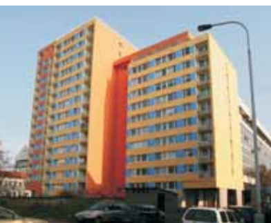
Zateplení bytového domu Dělnická, Praha 8, 2007/ External Insulation of Apart- ment Building Delnicka, Prague 8, 2007
