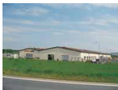
Opláštění haly Efaflex Olší, 2004/ Insulation of Industrial Halls, Efaflex Olsi, 2004
