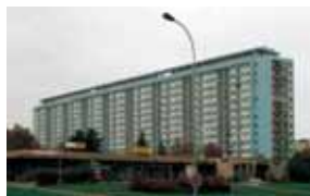
Zateplení bytového domu Šišková, Praha 8, 2006/ External Insulation of Apartment Building Siskova, Prague 8, 2006
