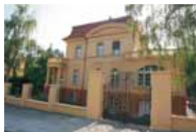
Rekonstrukce objektu Na Zátorce, 2007/ Reconstruction of Building Na Zatorce, 2007
