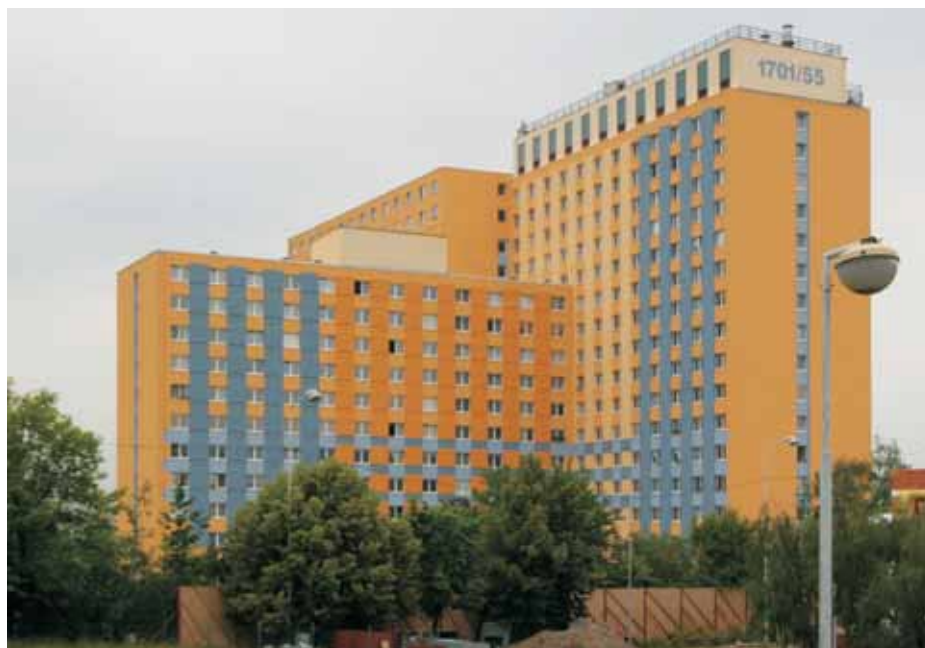
Štúrova, Praha 4 — za realizaci tohoto domu jsme obdrželi Cenu ředitele Baunit v soutěži Fasáda roku 2008/Sturova, Prague 4 — for implementation of this house, we received the Baunit Director Award in the Facade of the Year 2008 Competition
