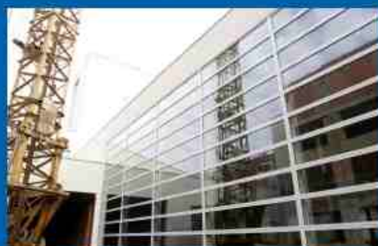
Rekonstrukce Galerie Holešovice
