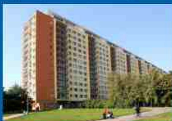
Zateplení bytového domu Slančova ul., Praha 8
