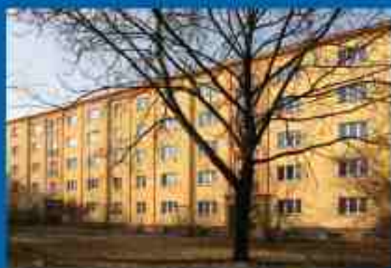
Zateplení bytového domu Nučická ul., Praha 10
