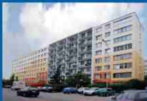
Zateplení bytového domu Jablonořská ul., Praha 10
