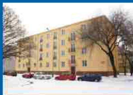
Zateplení bytového domu Plešharova ul., Praha 6
