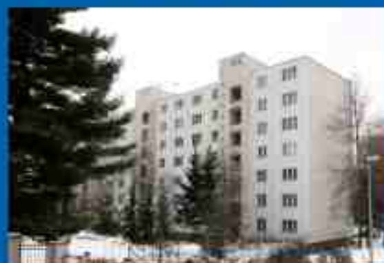
Zateplení bytového domu Vrátkovská ul., Praha 10
