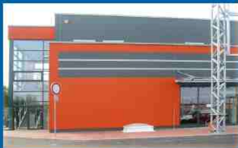
Opláštění haly Klášterec nad Ohří
