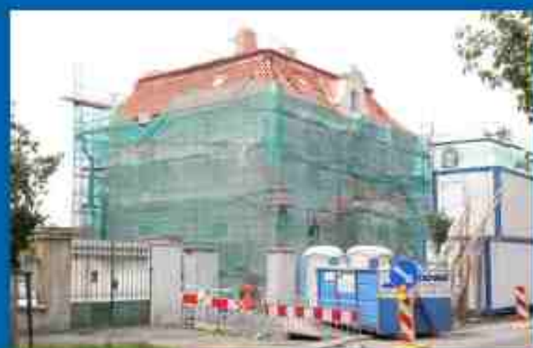
Rekonstrukce Dykova, Vinohrady
