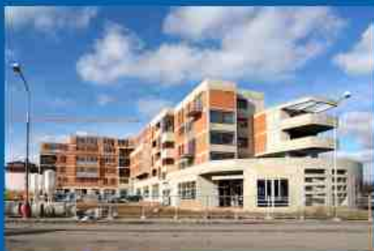
Bytové domy R2 a R3 Roztoky
