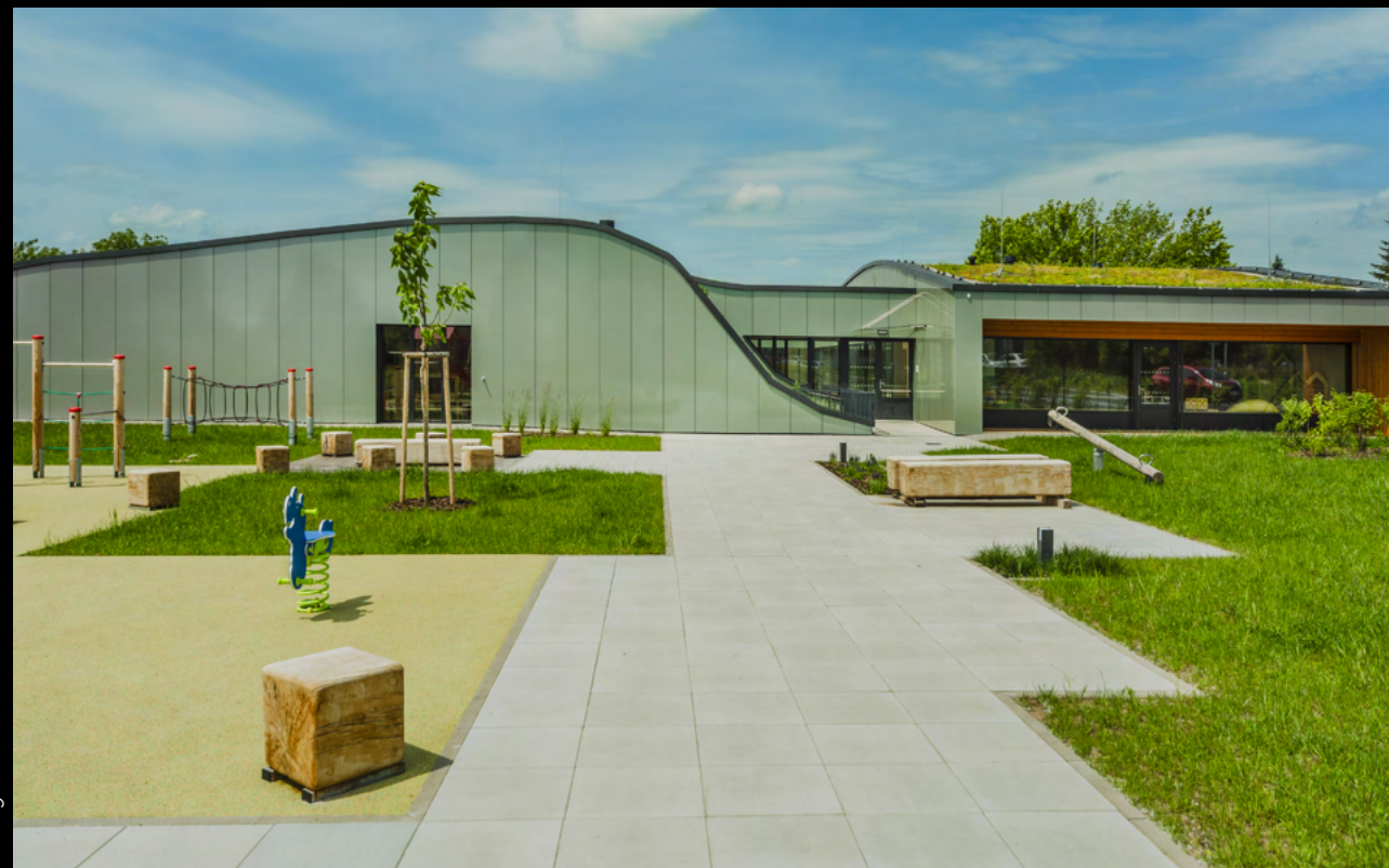
Mateřská škola Čáslav Kindergarten Čáslav
