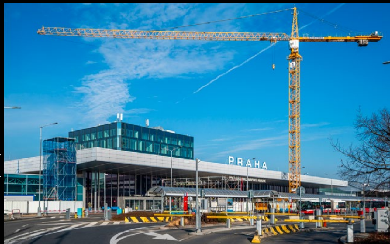
Terminál I, Letiště Václava Havla Praha Terminal I Václav Havel Airport Prague
