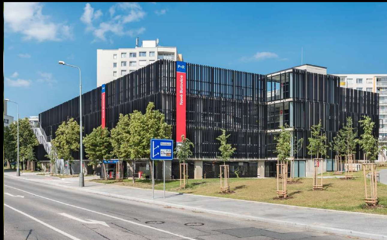
Parkovací dům Petřilkova, Petřilkova multi-storey car park
