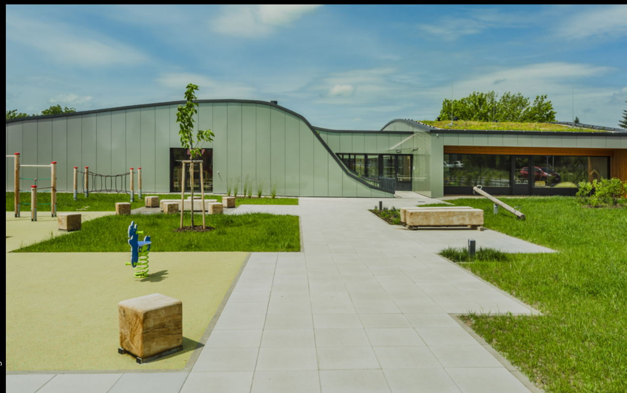
Mateřská škola Čáslav Kindergarten Čáslav
