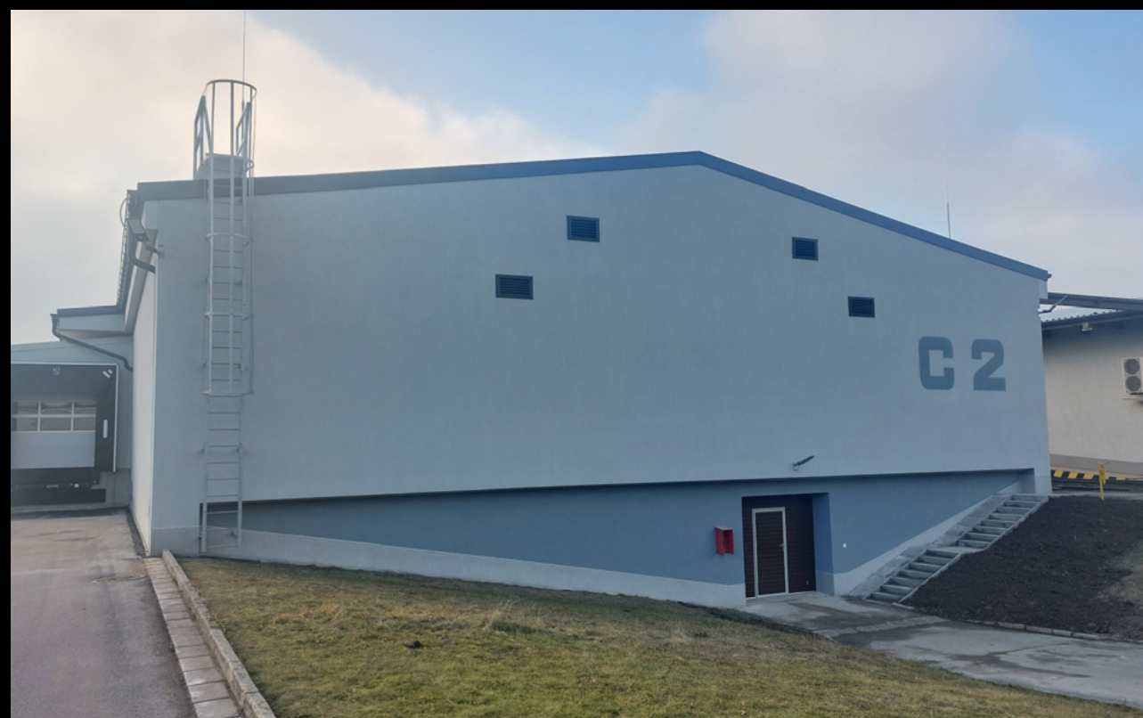
Rekonstrukce skladových hal SSHR, Polehrady Reconstruction of SSHR storage halls - Polehrady + Butoves
