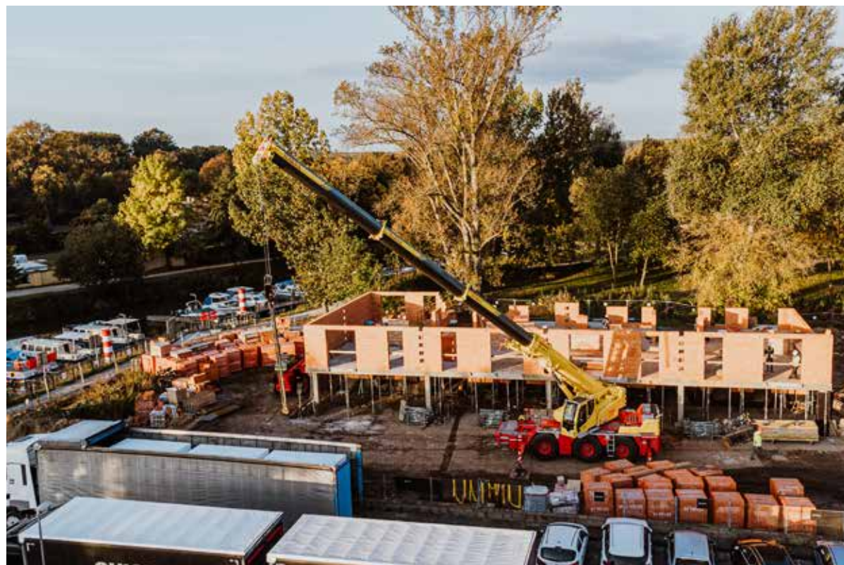
Výstavba ubytování, Veselí nad Moravou
