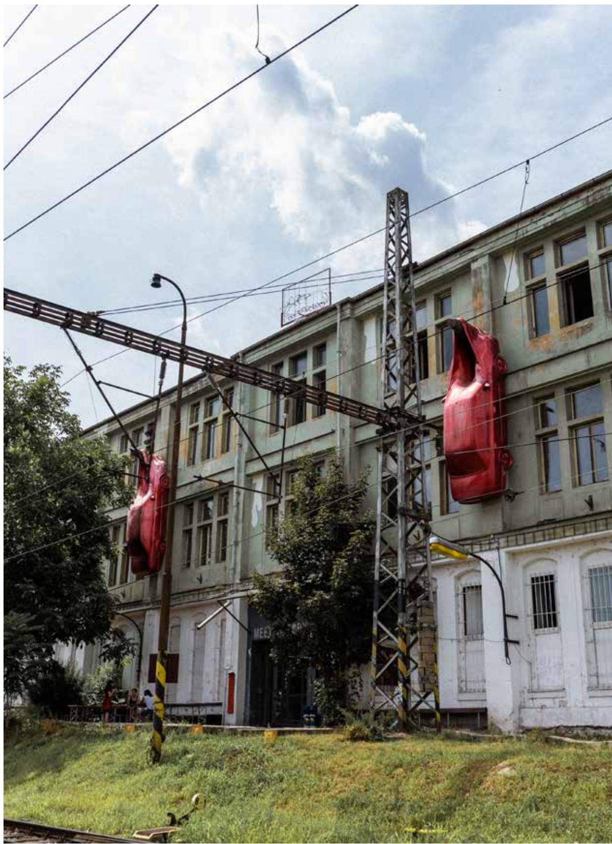
MeetFactory je neziskové mezinárodní centrum současného umění založené v roce 2001 umělcem Davidem Černým
