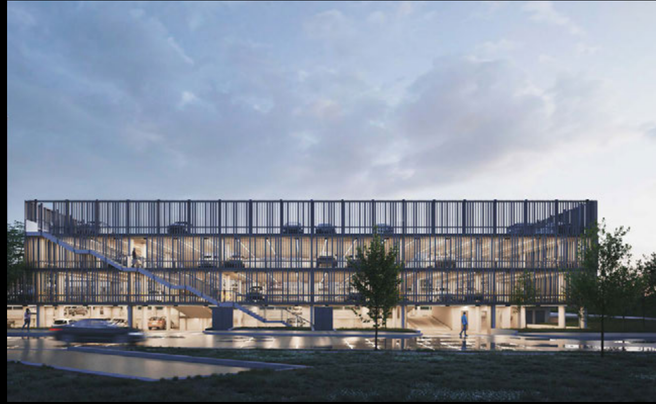
Parkovací dům Nové Butovice, Praha 13, Prague 13
