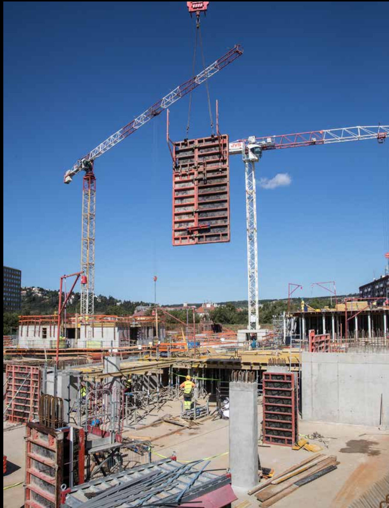
Výstavba projektu Bydlení Bráňník, Praha 4; Construction of the Bydlení Bráňník project, Prague 4
