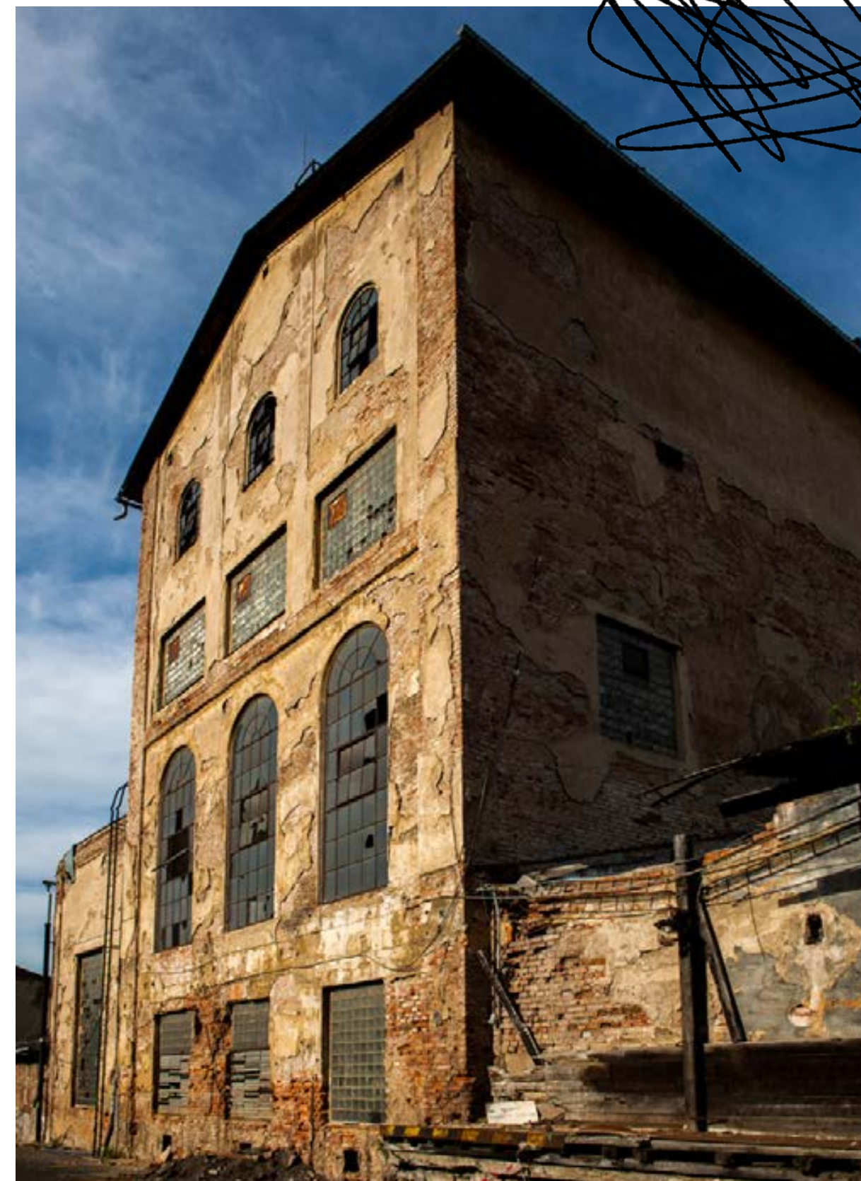
Várna Lihovaru Smíchov před rekonstrukcí, květen 2021
