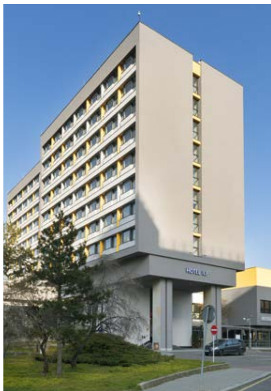
Zateplení hotelu ILF, Budějovické náměstí Praha 4
