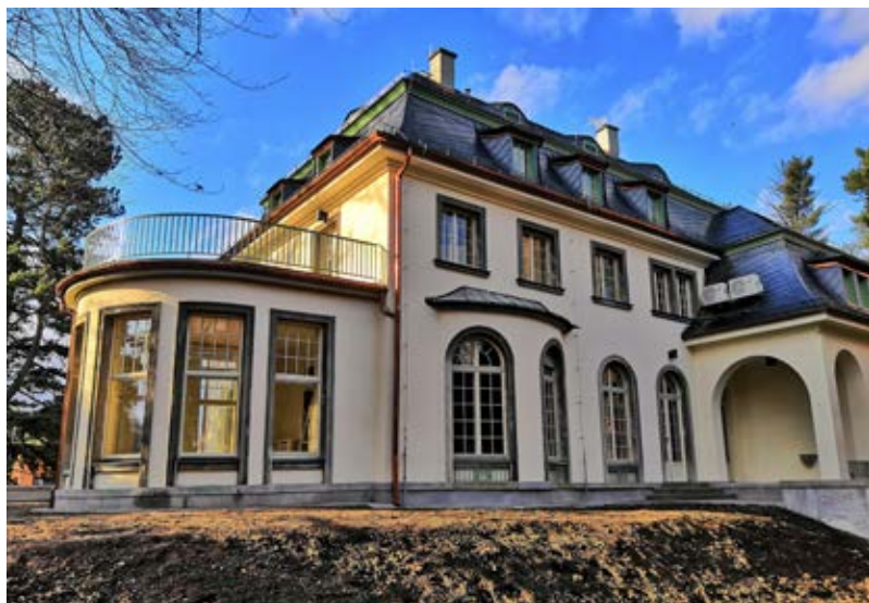
Rekonstrukce historické vily v Hrádku nad Nisou
