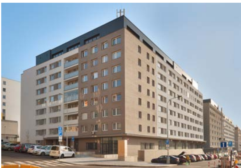
Zateplení bytového domu Roháčova, Praha 3
