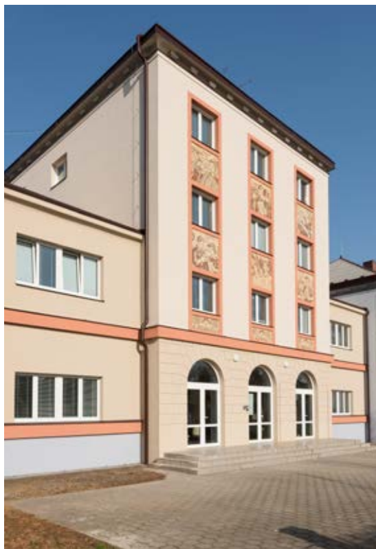
Zateplení a rekonstrukce SOŠ a SOU Čáslav
