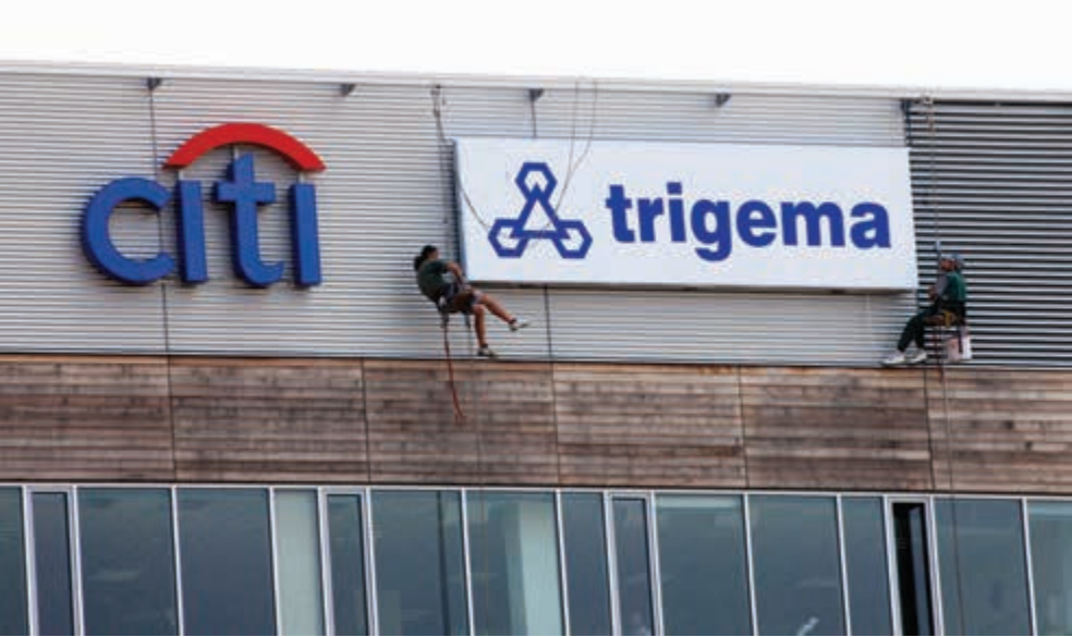
Foto z instalace nového loga na centrálu firmy v Nových Butovicích
