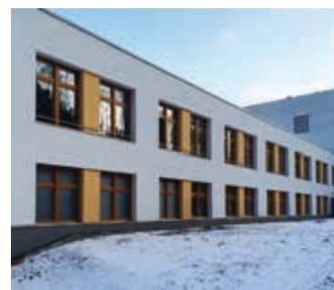
Zateplení školy Železný Brod
