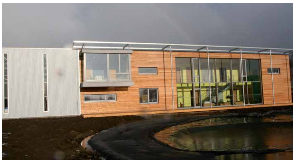
Novostavba administrativních budov a haly pro společnost Nelumbo, Otovice u Karlových Varů.
