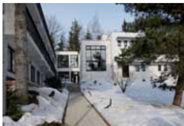
Provedli jsme rekonstrukci školního střediska NKÚ v Přestavlkách u Slap.
