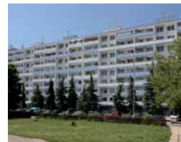
Zateplování fasád v roce 2011 (shora) Ovčí hájek, Praha 5 Chalabalova, Praha 5 Malkovského, Praha 9 Rýmařovská, Praha 9 Švédská, Kladno:
