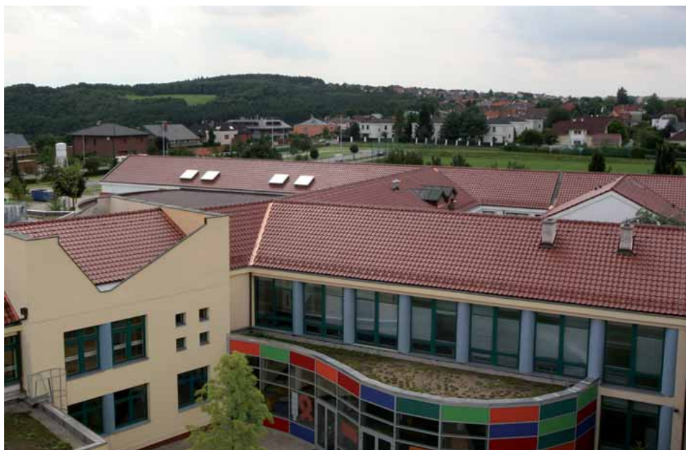
Třetí zakázka pro International School of Prague v Nebušicích - kompletní rekonstrukce střešních krytin.
