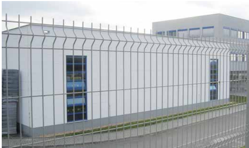
Opláštění hal v Touškově, Černici a Nýřanech
