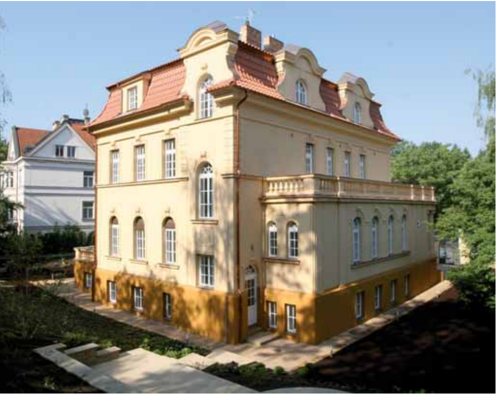
Rekonstrukce rezidence Dykova ulice, Praha 2
