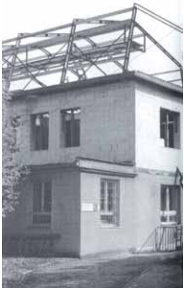
Rekonstrukce Limuzská, Praha 10 - - ocelový krov
