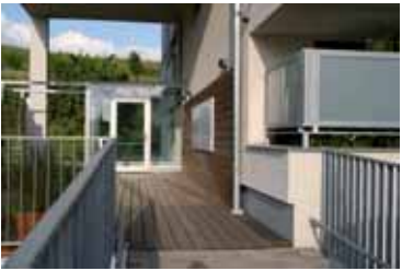
Zároveň jsou ukázkou netuctové architektury. Bezbariérové vstupy jsou již samozřejmostí.
