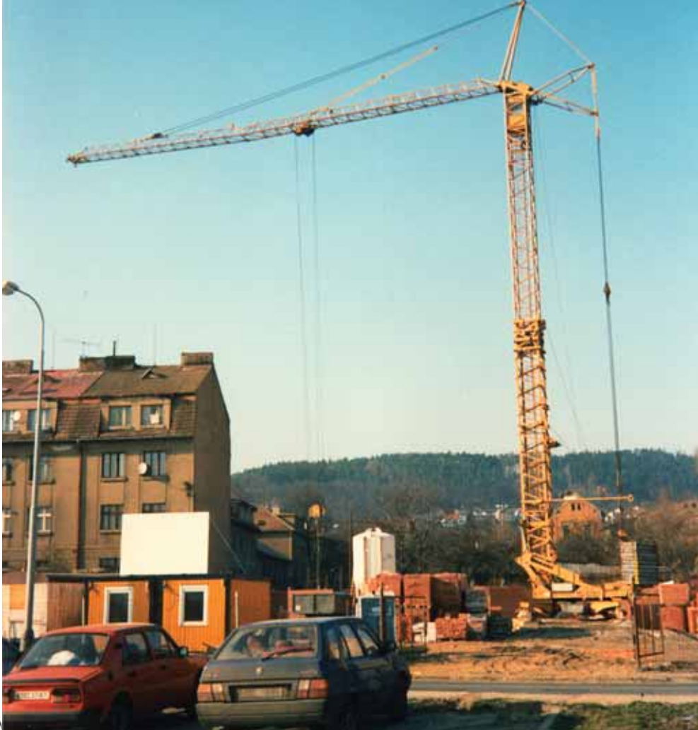
Zahájení výstavby bytového domu v Tachovské ulici
