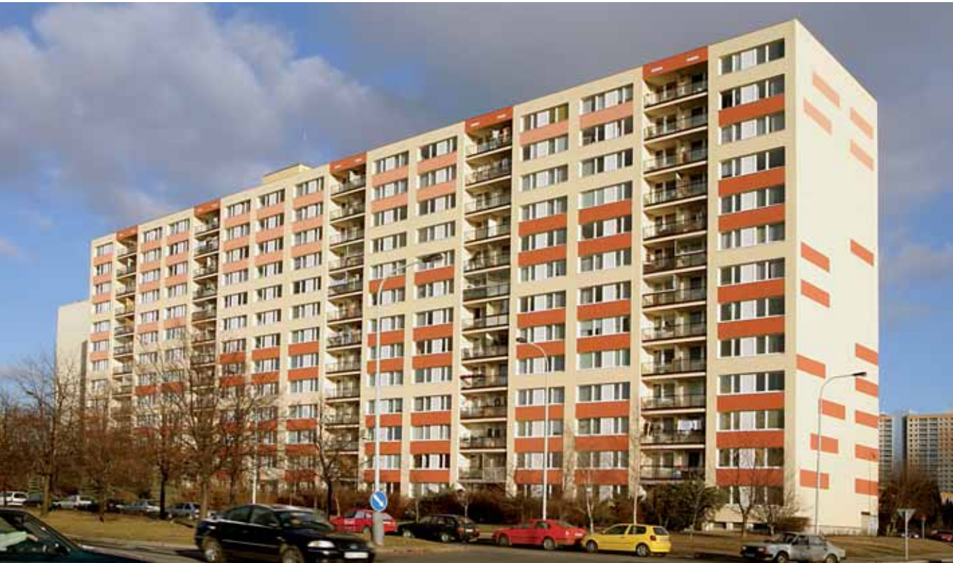
Zateplení Lodžská, Praha 8
