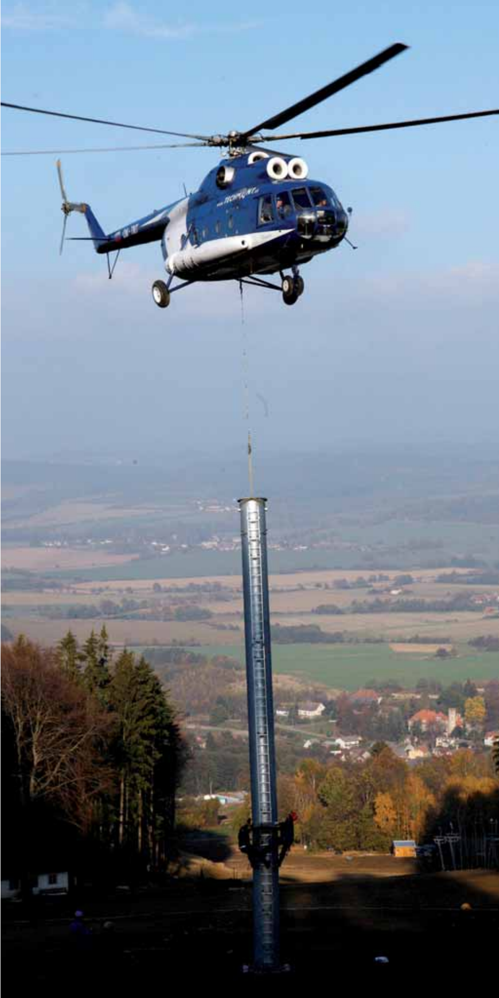
Osazování sloupů lanovky pomocí vrtulníku byla dramatická podívaná a vyžadovala dokonalou souhru všech pracovníků.
