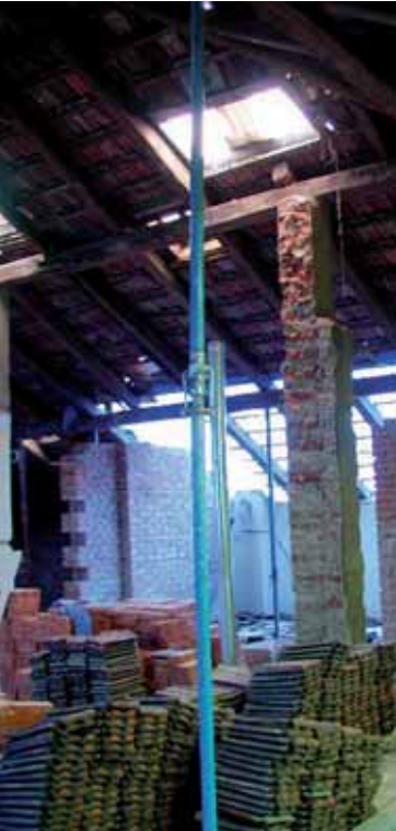
Rekonstrukce vilového domu Dobřichovice dle návrhu architekta Vávry
