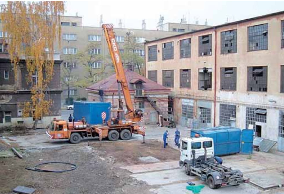
Rekonstrukce bývalé továrny na uměleckou galerii v Praze-Holešovicích. Stav objektu před rekonstrukcí byl tristní.
