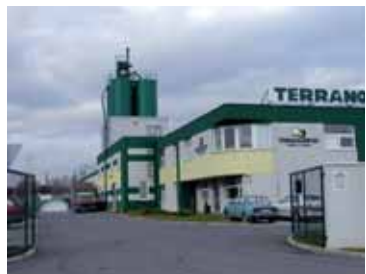
Opláštění haly Terranova Štěrboholy
