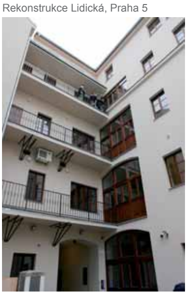
Rekonstrukce Lidická, Praha 5
