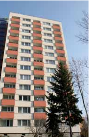
Zateplení bytového domu Evropská
