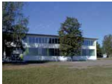
Opláštění haly Intersoft Plzeň
