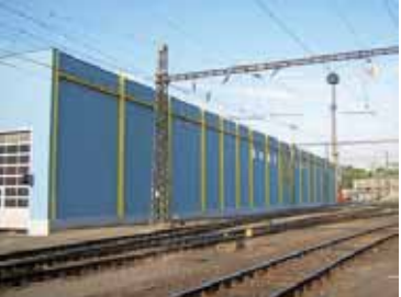
Myčka kolejových vozidel Praha
