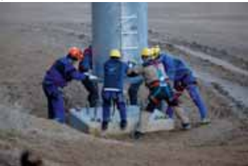
Osazování sloupů lanovky pomocí vrtulníku byla dramatická podívaná a vyžadovala dokonalou souhru všech pracovníků.
