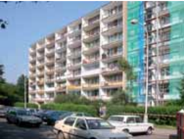
Zateplení Bílinská, Praha 9
