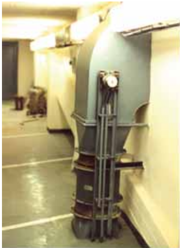
Oprava garáží v suťrénu finanční- ho úřadu v Praze 2
