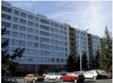
Zateplení bytového domu Červenková v Praze 8
