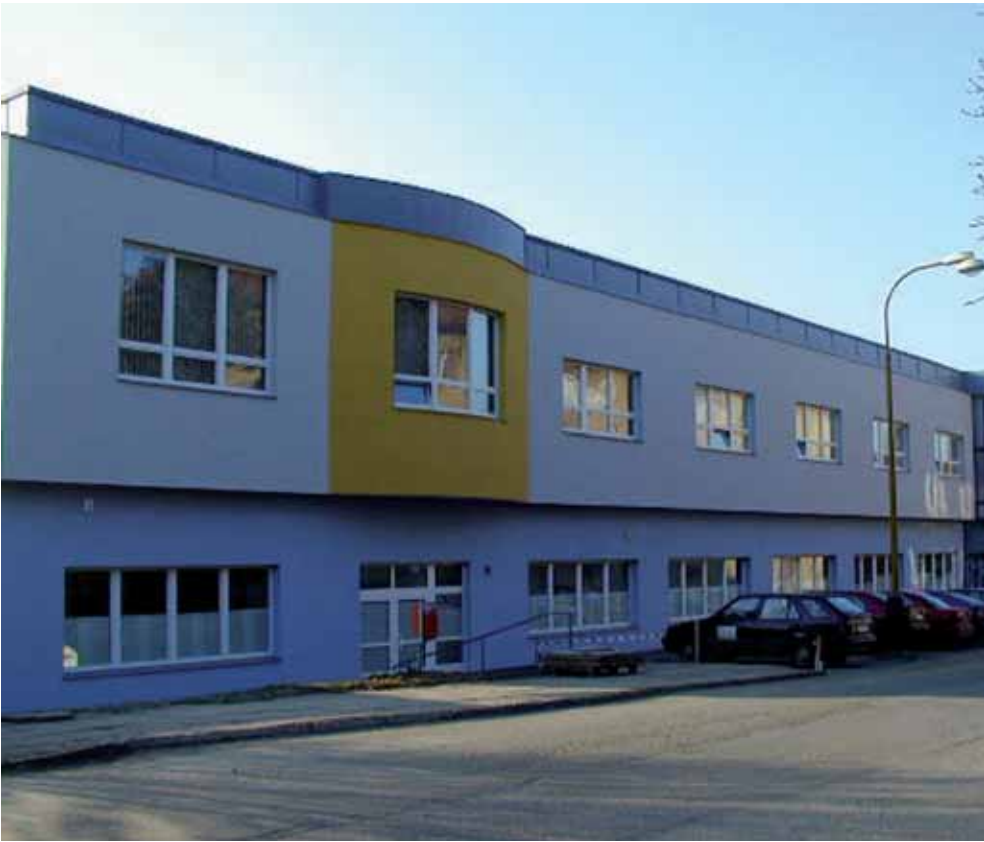
Rekonstrukce GAS Říčany
