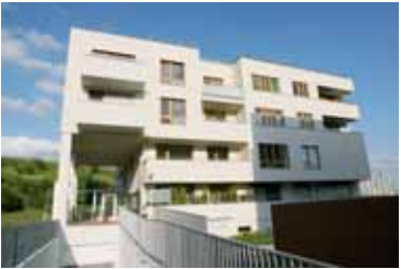
Bytové domy E a F v obytném souboru Nová kolonie představují moderní trend ve výstavbě bytů - viladomy s malým počtem bytů.
