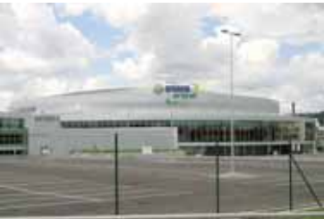
Na výstavbě Sazka Arény jsme se podíleli dodávkou protipožárních ucpávek stěnových prostupů.
