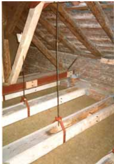
Rekonstrukce u Marčánů - strop zavěšený do krovu
