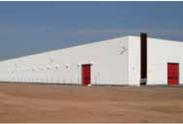
Opláštění haly EFAPLEX Olší
