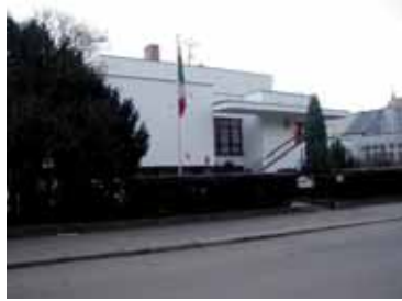
Stavební opravy ZÚ Mexiko
