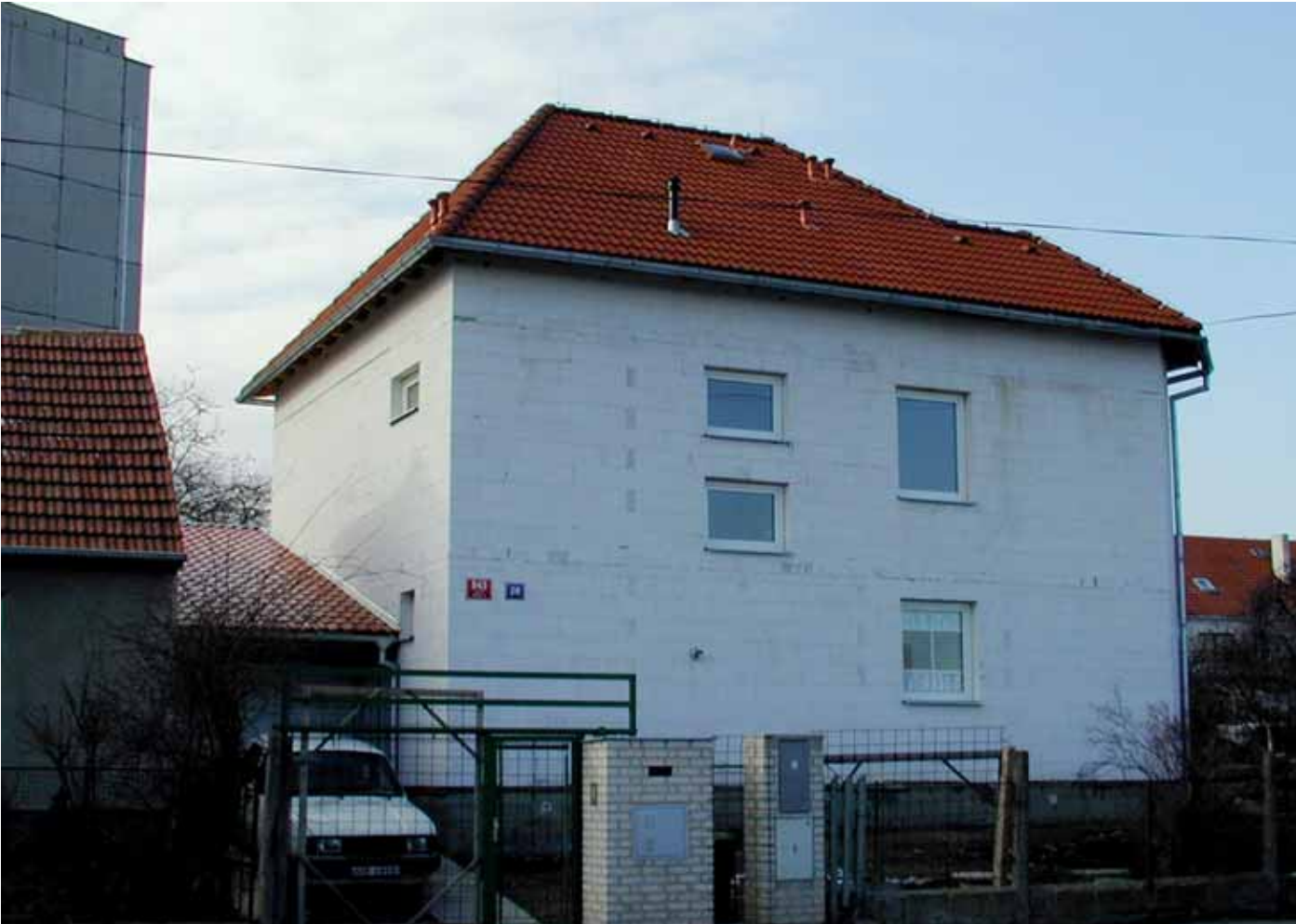
Hrubá stavba rodinného domu Háje
