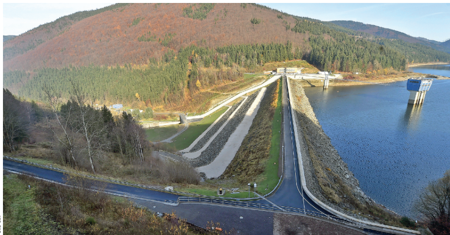
NA HORNÍM TOKU ŘEKY OSTRAVICE v Moravskoslezských Beskydech skončila generální oprava přehrady Šance. Největší rekonstrukce v historii vodního díla začala v září 2015 a stála přes 438 milionů korun. Přehrada je v regionu stěžejní nádrží pro zásobování pitnou vodou Novojičínska, Frýdecko-Místeka, Ostravy či části Karvinska. Do užívání byla předána v roce 1969.
